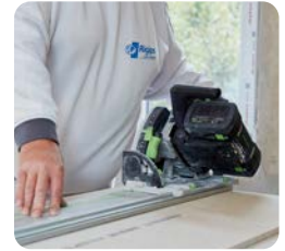
Für den Wandanschluss ist der Stufenfalz abzutrennen
