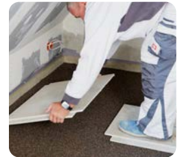
Verlegung der Estrichelemente auf Rigidur Ausgleichschüttung mit Hilfe von Laufinseln
