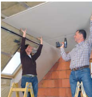
Decke mit versteckten Kehlbalken
