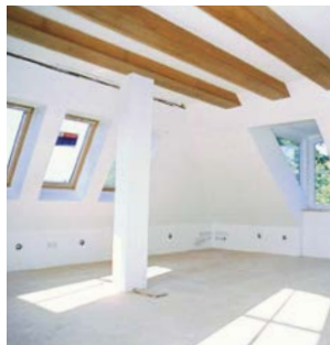
Decke mit sichtbaren Kehlbalken
