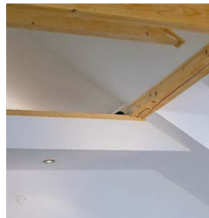
Kehlbalkendecke bzw. Galerie / Empore
