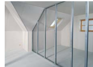
Ständerwerk montieren
