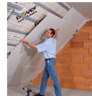
Verkleidung der Dachschräge
