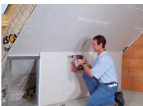
Abseitenwandverkleidung
