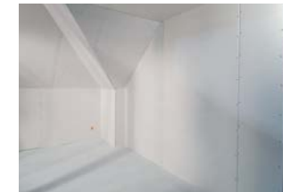
Fugen und Anschlüsse verspachteln und Oberflächen beschichten
