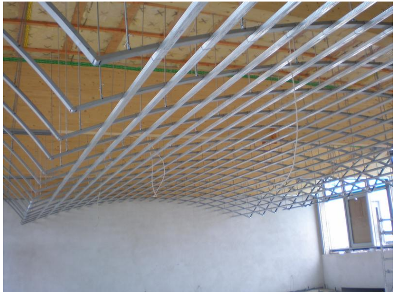
Bild 1: Ansicht des Deckenrostes Gymnasium Atrium, Hagenow Ausbau eines Schulgebäudes im Rahmen einer Sanierung mit einer gewölbten abgehängten Decke.
