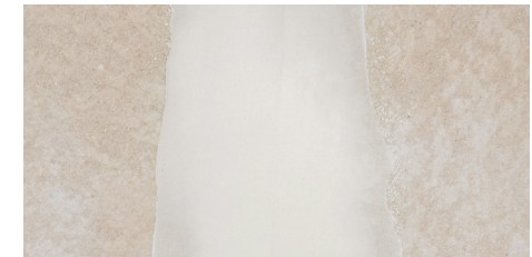
Fugenbild mit Rigidur in Klebefugentechnik auf Stoß stumpf verlegt und mit Rigidur Nature Line Fugenkleber verklebt - Über-spachtelung der Fuge und Befestigungsmittel mit Rigips VARIO Rigidur Fugenspachtel.
