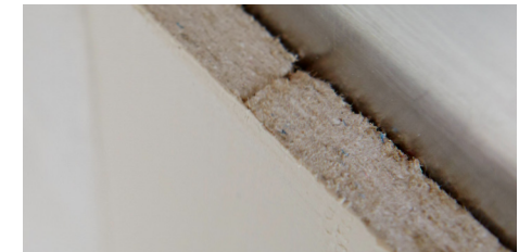
Der Fugenspalt beträgt weniger als 1 mm. Der Kleber muss die gesamte Fuge ausfüllen.
