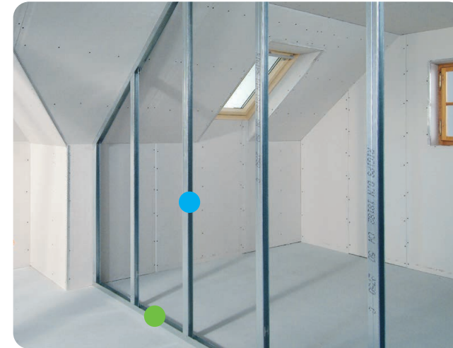
Ständerwand mit CW- und UW- MultiTec Profilen als nicht-tragende Trennwandunterkonstruktion
