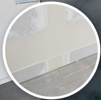
Fertige Abschlusskante mit rückspringendem Sockel
